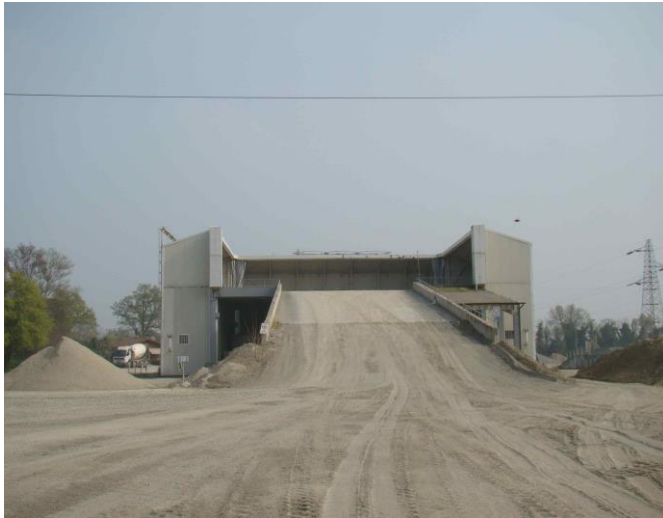
Rampa di accesso alle tramogge inerti
