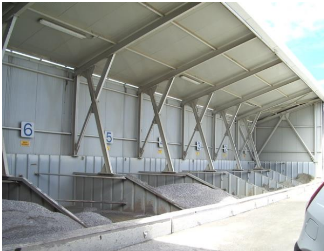
Vista aree di scarico inerti
